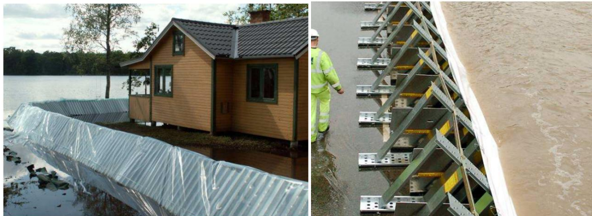
Figur 19. De helt temporära skydden DamLite till vänster och Aqua Barrier till höger (foton Terra Firma 2008)
