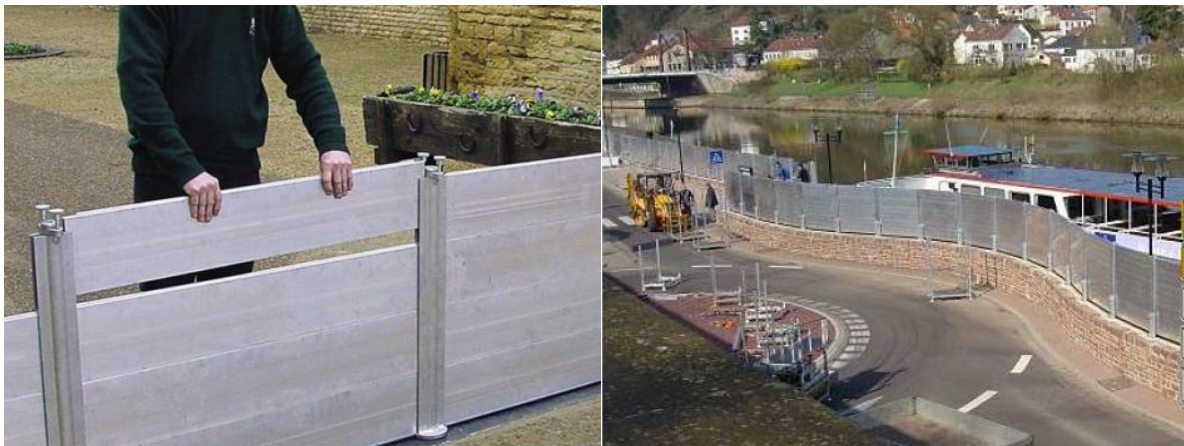
Figur 18. De halvttemporära skydden WaterWall till vänster och IBS till höger (foton Terra Firma 2008)
