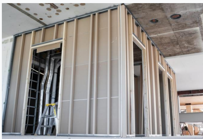
Figur 42: Reglar i papper installerade i Strömshuset. Foto från (112).
