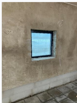
Figur 46: En av Hoppets komplementbyggnader byggd av hampakalk (foto: Maria Perzon).
