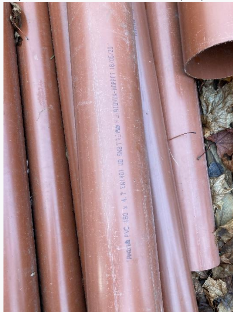
Figur 43: Biosubstituerad plast i markrör till förskolan Hoppet (foto: Maria Perzon).
