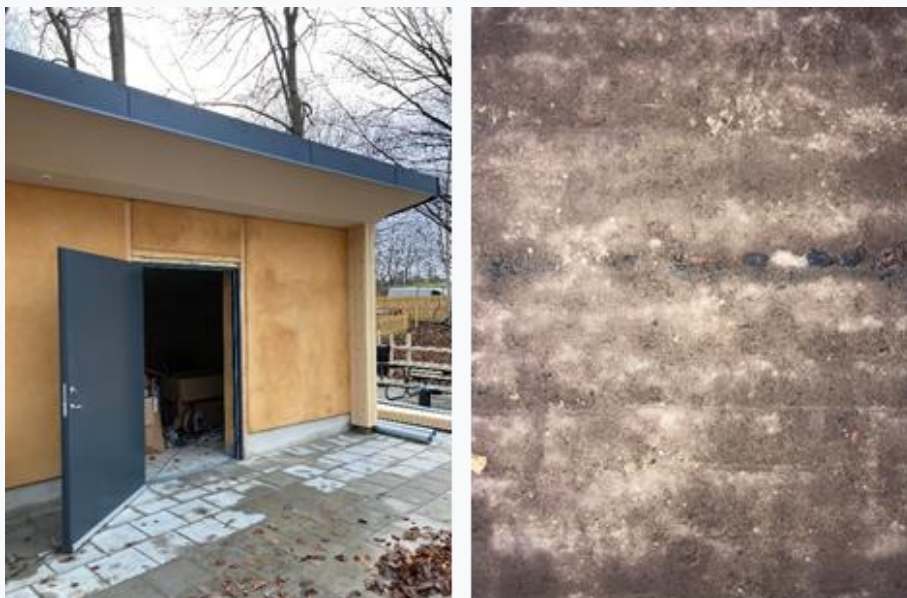
Figur 45: En av Hoppets komplementbyggnader med en vägg av lera (foto: Maria Perzon).
