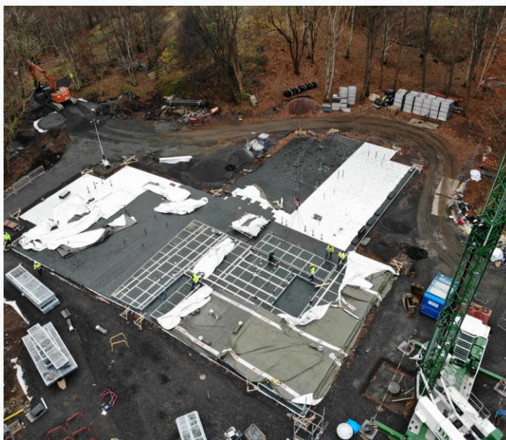
Figur 39: Hoppets grund av FOAMGLAS/Koljern (foto: Lokalförvaltningen).
