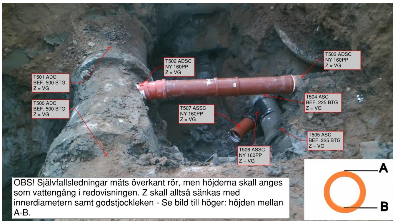
Bild 4: Nylagda spill- och dagvattenserviser.
