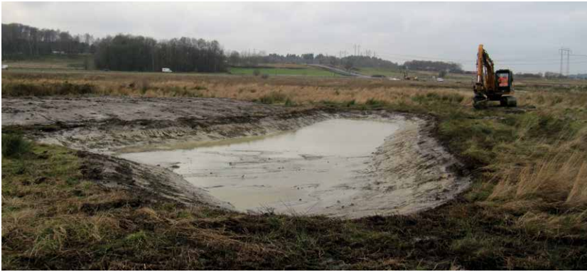
Nyanläggning av damm i Hökålla
