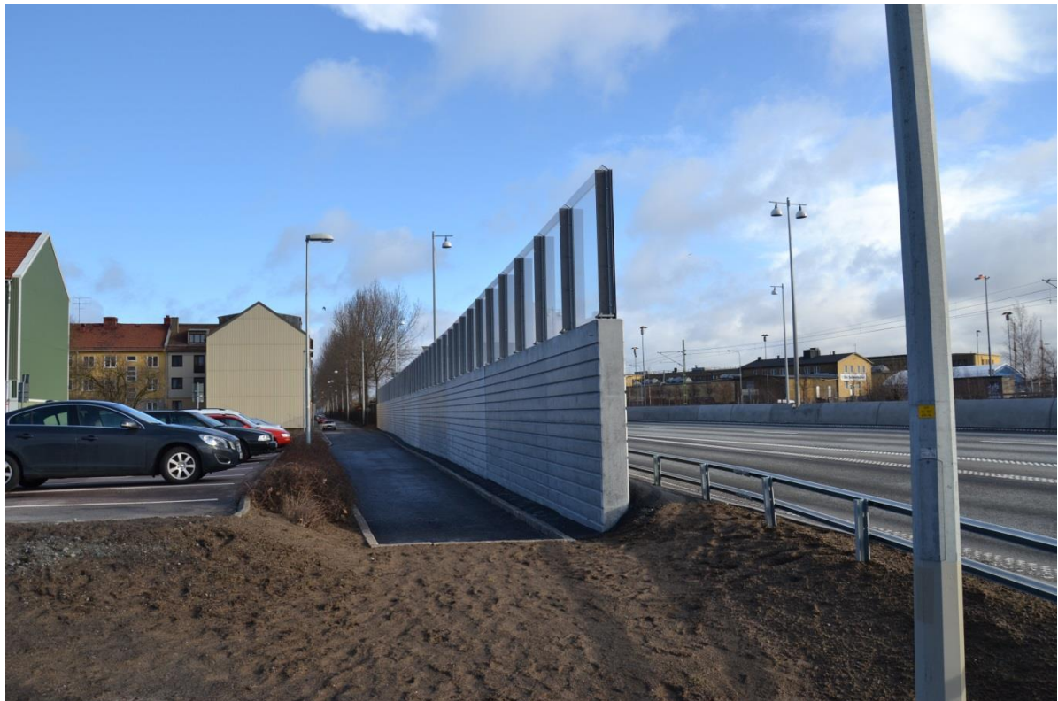
Figur 19 Skyddsmur av armerad betong som även kan användas som bullerskärm längs vägar.
