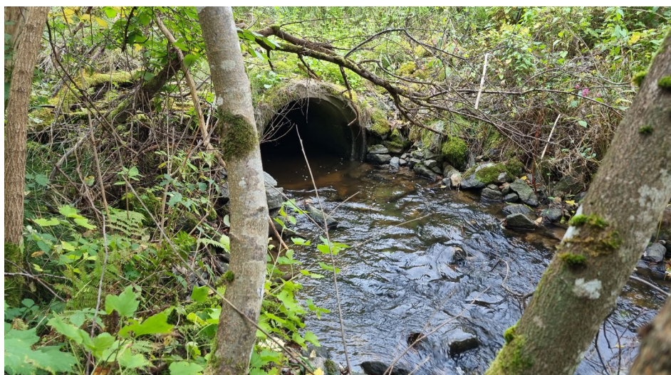
Figur 4.18 Trumman under Rosenhöjdsvägen.
