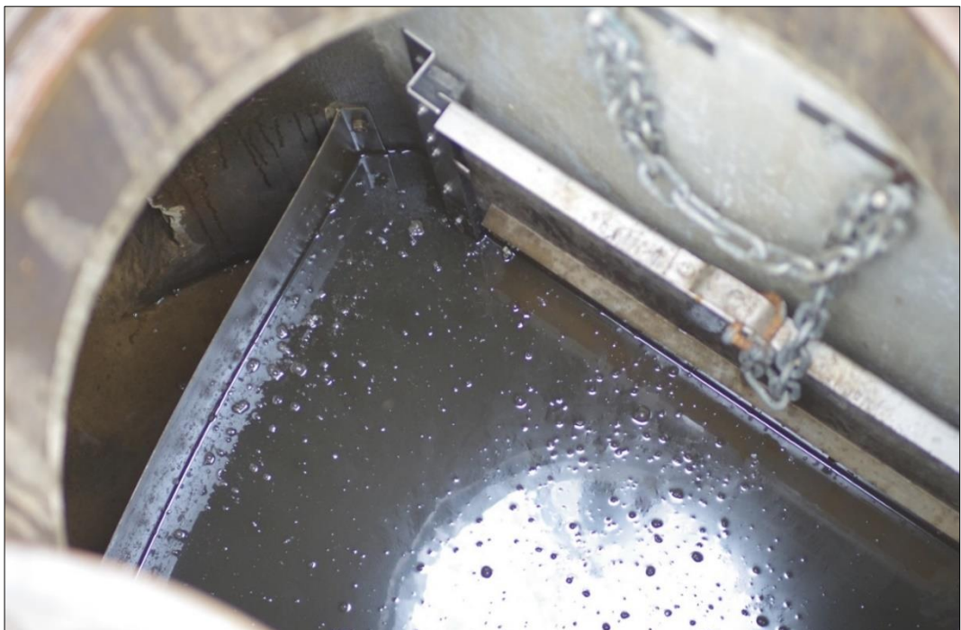
Figur 20. Exempel på inloppsanordning till damm i brunn på befintlig dagvattenledning. Ett rostfritt dämme till vänster tvingar in dagvattnet i dammen när luckan till höger är öppen. När luckan är stängd passerar vattnet över dämnet och bräddar då förbi dammen. Foto WRS.
