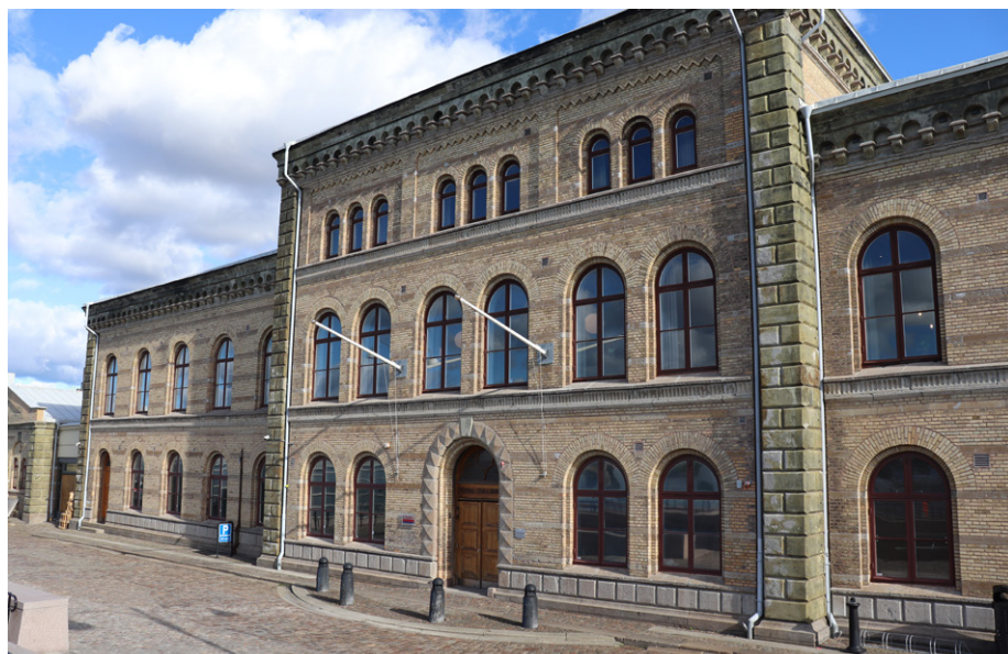
Foto: Göteborgs gamla tullhus
