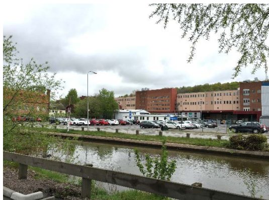
Befintlig industribebyggelse öster om Nellickevägen
