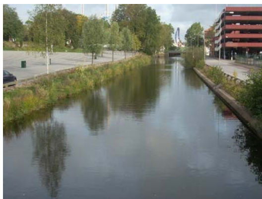
Mölndalsån, södra delen av område, vy från söder med naturlig slänt väster om ån och stödmur öster om ån.
