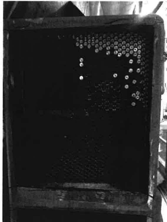
Pluggade tuber efter läckage
