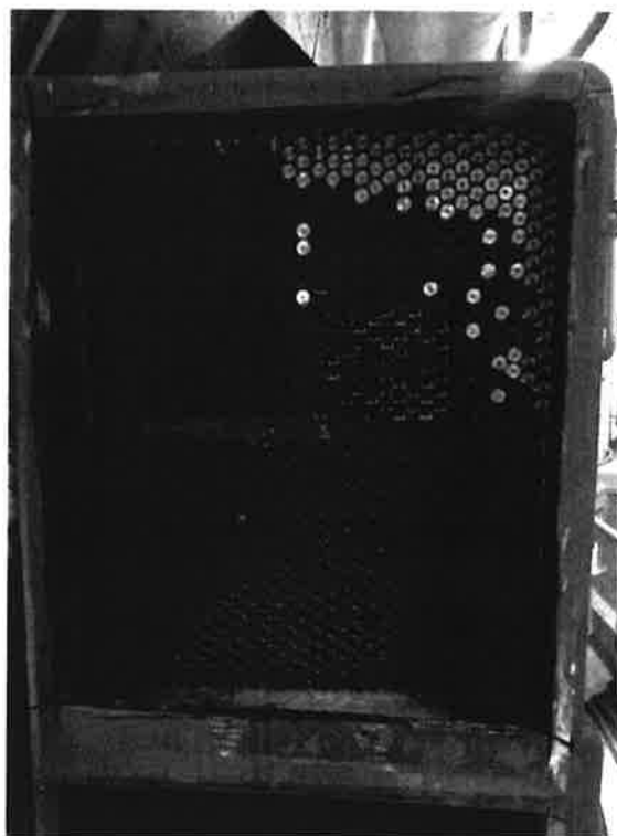
Pluggade tuber efter läckage
