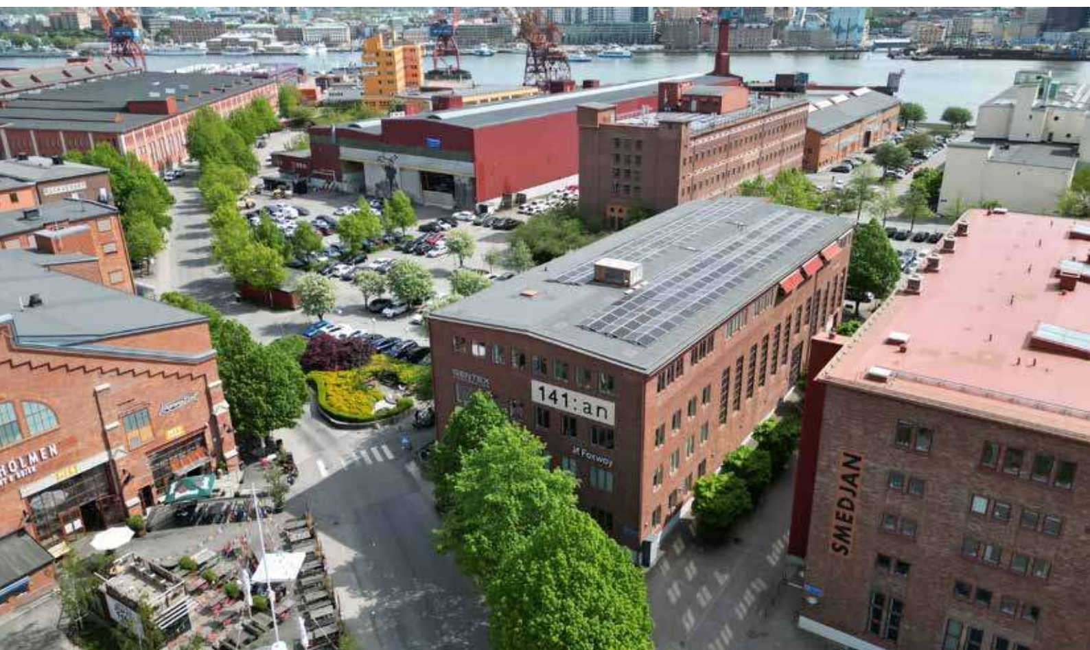
Vy över delar av vårt bestånd på Lindholmen och Götaverksområdet. Bland annat syns byggnaderna M1:an, 141:an, Träverkstaden, RE-garaget, Centralstationen, Plåtverkstaden, Riverside och Galjonen.
