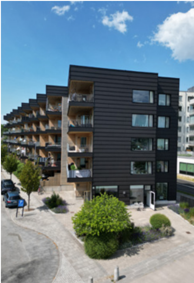
Däckshuset i Sannegårdshamnen.
