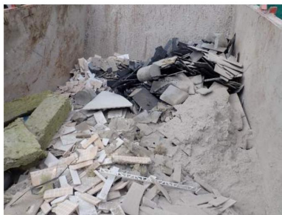
Figur 4. Stickkontroll på containrarna – korrekt fyllda.
