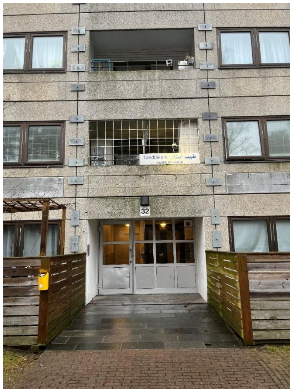
Befintlig fasad inklusive förstärkning av fasadelement
