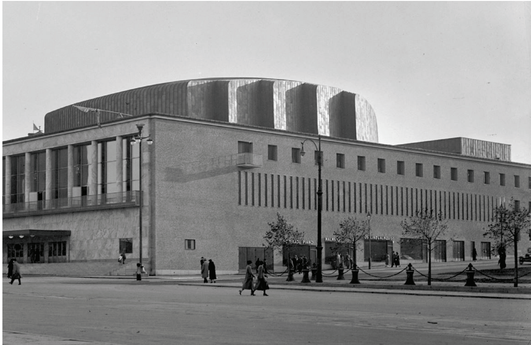
EXTERIÖRBILD FRÅN 1935 - FASAD MOT GÖTAPLATSEN, HÄMTAD FRÅN VOU PLANEN
