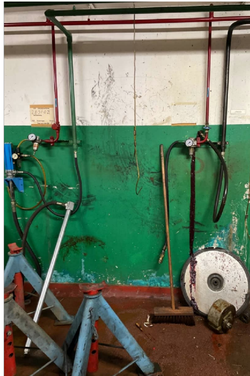
Figur 10. Två av tapparna på väggen i källaren (transmissionsolja till vänster och chassifett till höger).
