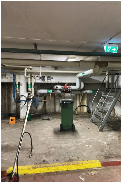
Figur 9. Källare där invallning av golvet syns i nedre delen av bilden. Till höger i bilden syns en trappa som leder till verkstadsgraven.
