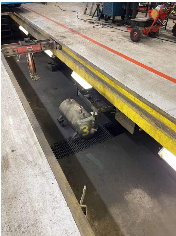
Figur 8. Botten av en så kallad grav där olja och övrigt farligt avfall samlas upp i en behållare som sedan töms genom ett slutet system.
