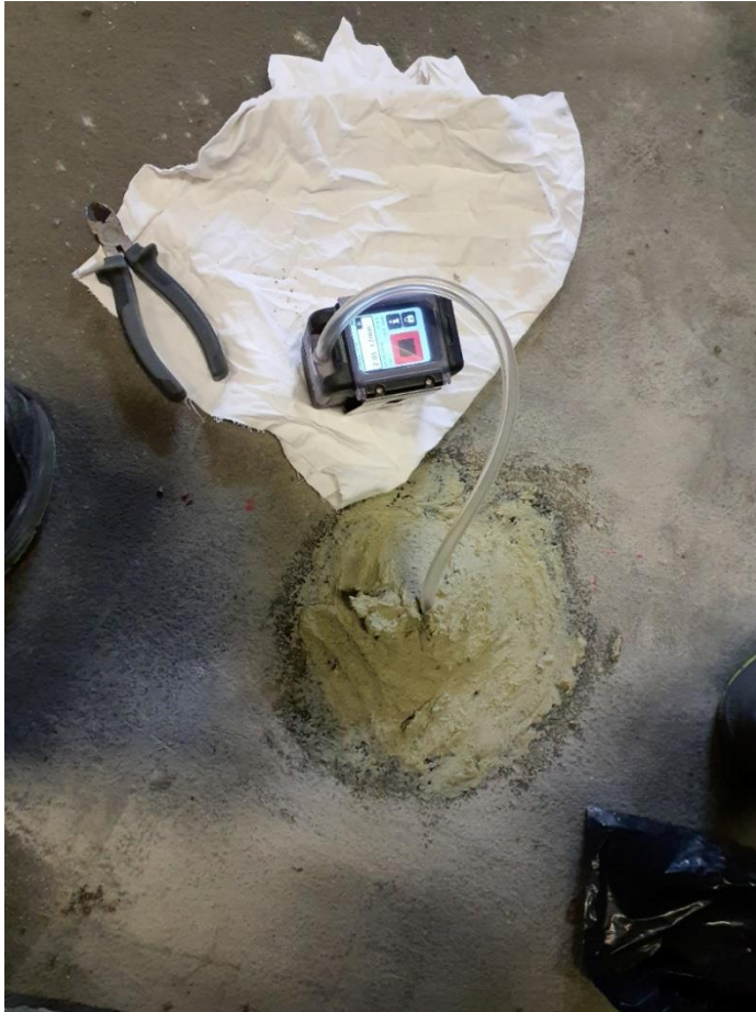
Figur 3. Installerad provtagare i provpunkt 25LCP01. Borrhålet tätat med bentonit och pumpen startad.
