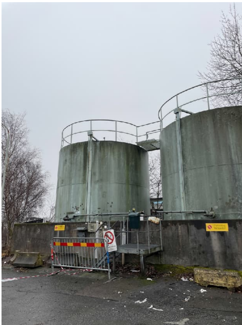
Figur 16. Två dieselcisterner utomhus. Tanken vänster i bild (södra tanken) är i bruk och cisternen till höger i bild (norra tanken) är tömd och sanerad.
