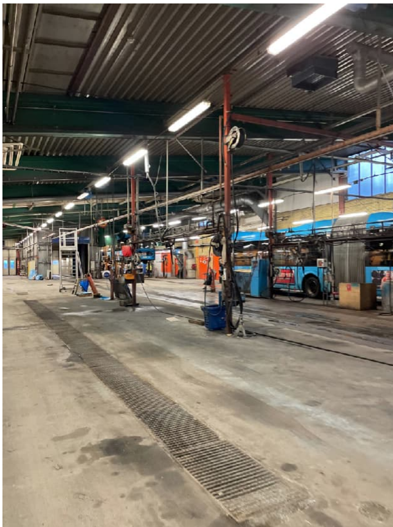
Figur 15. Tvättshall med slamränna och fläckar på golvet.
