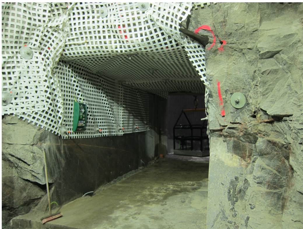
Nischen inne från befintlig tunnel.
