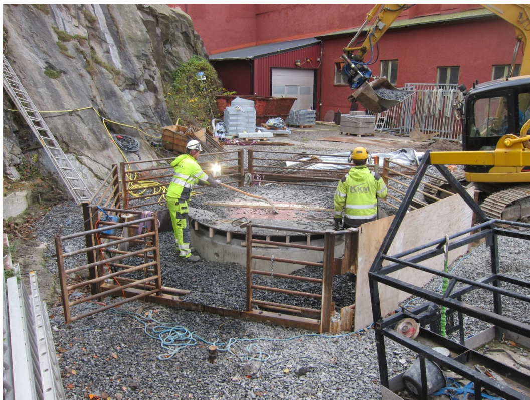
Arbetet med montage av betong ringar klart.
