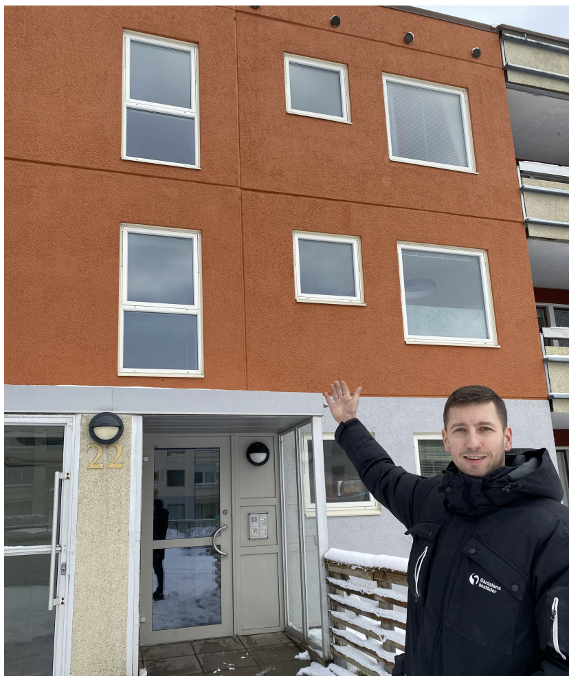
Fasadrenovering i västra Gårdsten.
