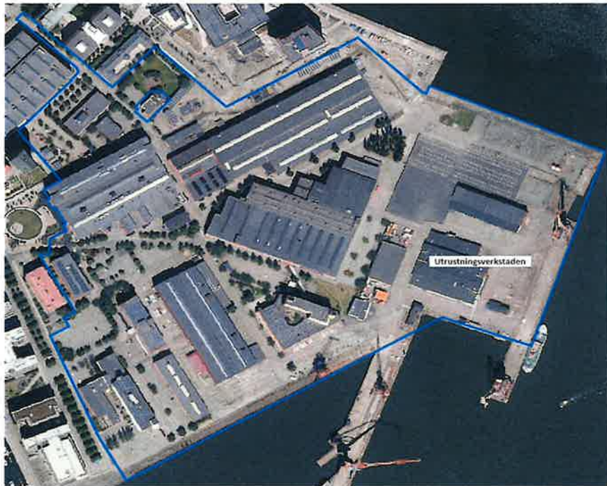
Flygfoto från 2022 över Lundbyvassen 4:6.
