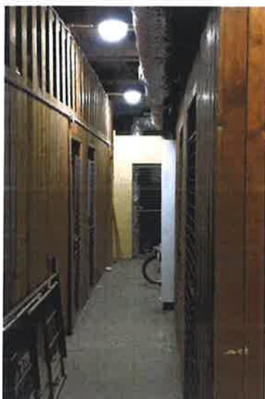
Vind i Haga före ombyggnation.
