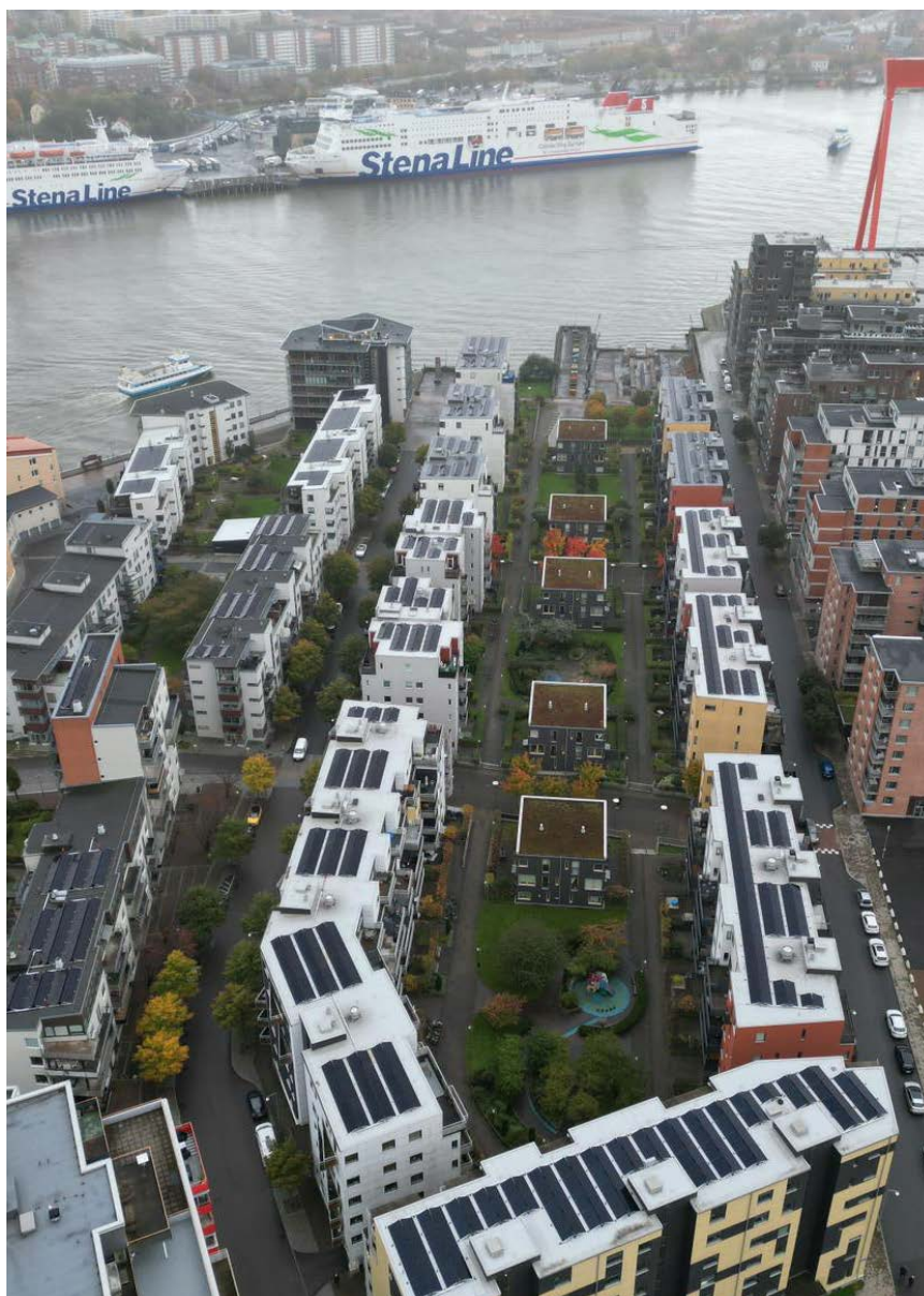
Våra hus på Eriksberg har fått nya solceller.
