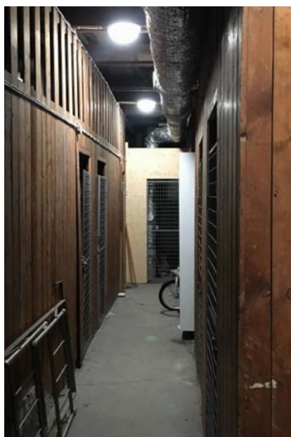
Vind i Haga före ombyggnation.
