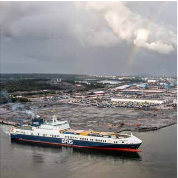
Pågående kajbygge av Arendal 2, etapp 1c.
