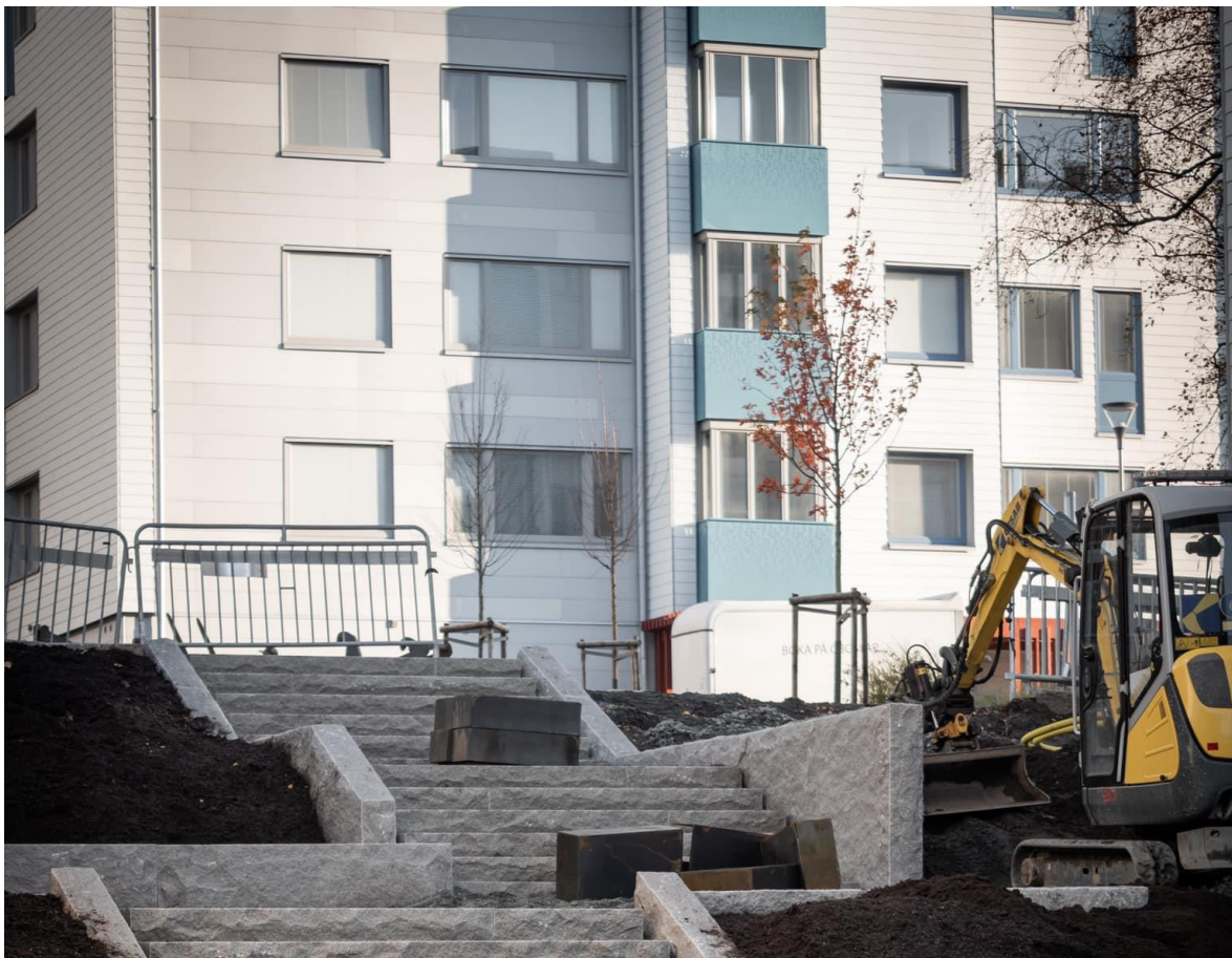
Pågående utvändig renovering av nedre området etapp 1-4.
