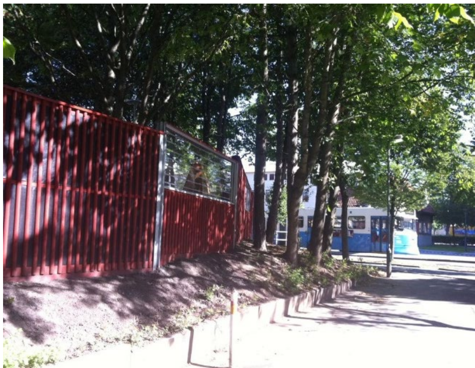
Figur 14. Bullerskärm vid förskolegård, exempel på lokal åtgärd vid bullerutsatt läge.
