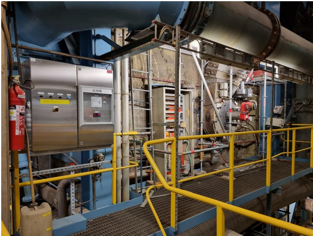
Gamla brännare. Elutrustning kvar. Isolering kvar. Plåt borttaget.
