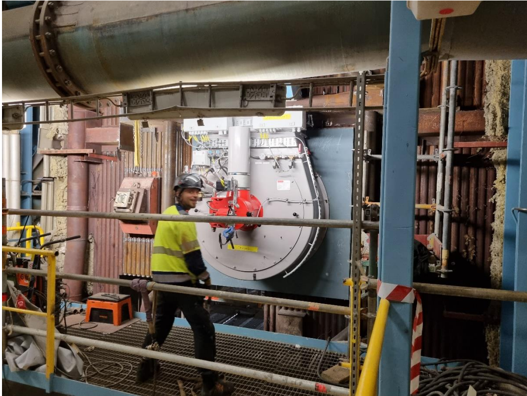
Ny brännare monteras. Glad entreprenör.
