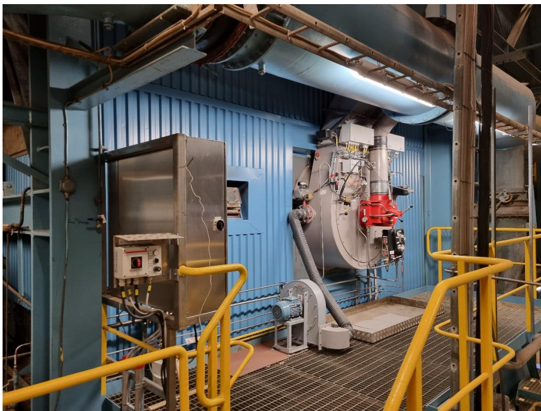
Installation brännare klar. Revision klar.
