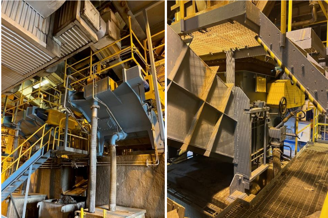
Befintliga slaggläckare.
