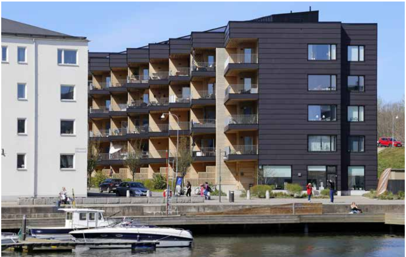
Däckshuset utnämndes 2016 till Göteborgs bästa byggnad
