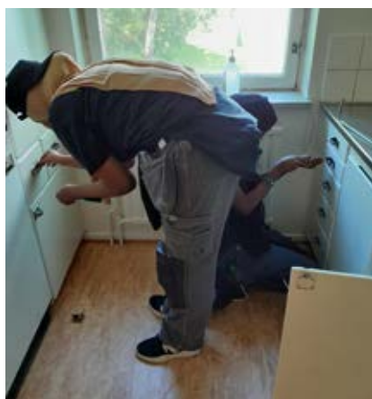
Extrajobbande ungdomar skruvar loss beslag i kök som ska renoveras.
