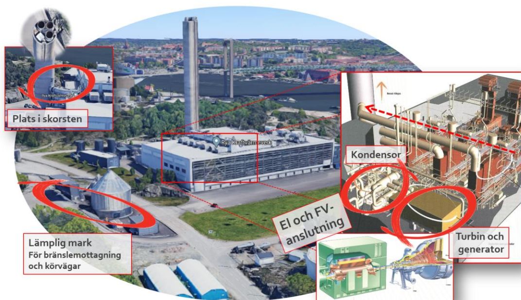
Figur 9. Förutsättningarna för att ansluta och integrera nya BKV Rya med befintligt kraftvärmeverk är goda då befintlig utrustning kan samutnyttjas.
