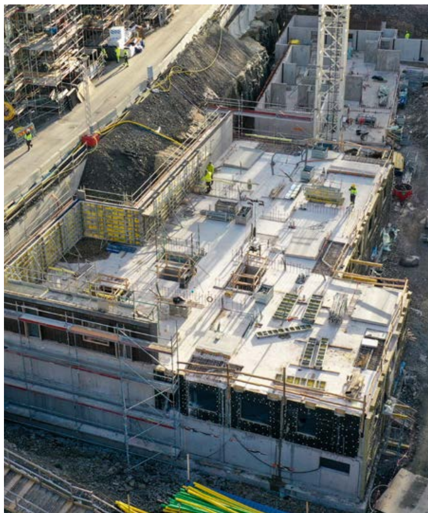
Bygget är igång i Östra Källtorp.
