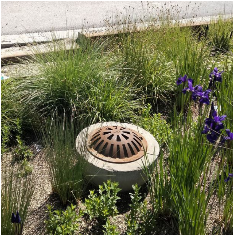
PLANTERING MED DAGVATTENHANTERING OCH BRÄDDAVLOPP, ATKINS SVERIGE AB 2022-06-09
