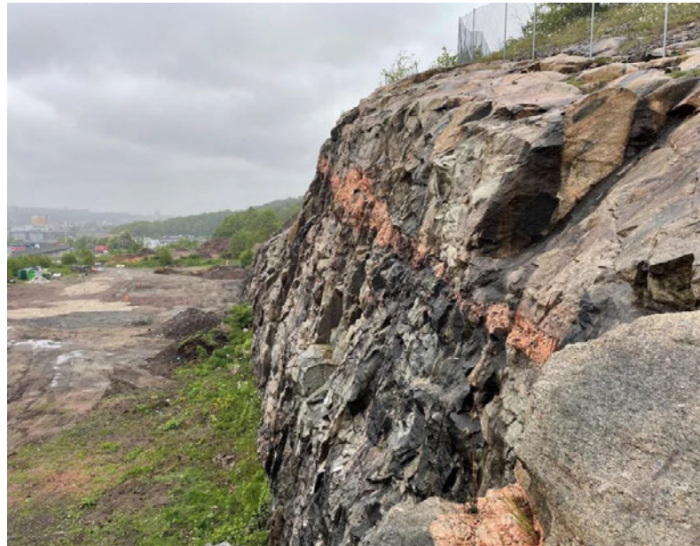
FASTIGHET OCH BERGSLÄNT - VY MOT NORDVÄST, NORCONSULT 2022-06-09
