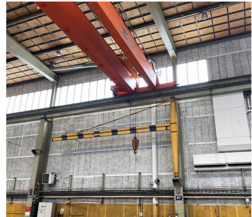
TRAVERSER PÅ LINDOLMEN SOM UTRETTS FÖR ÅTERBRUK, HIGAB 2022-06-20
