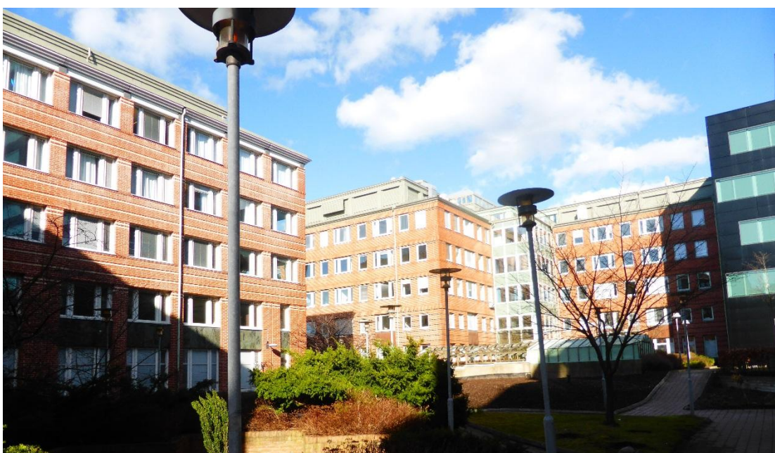
Byggnaderna inom Gårda 18:19 och 18:22 sedda från gården
