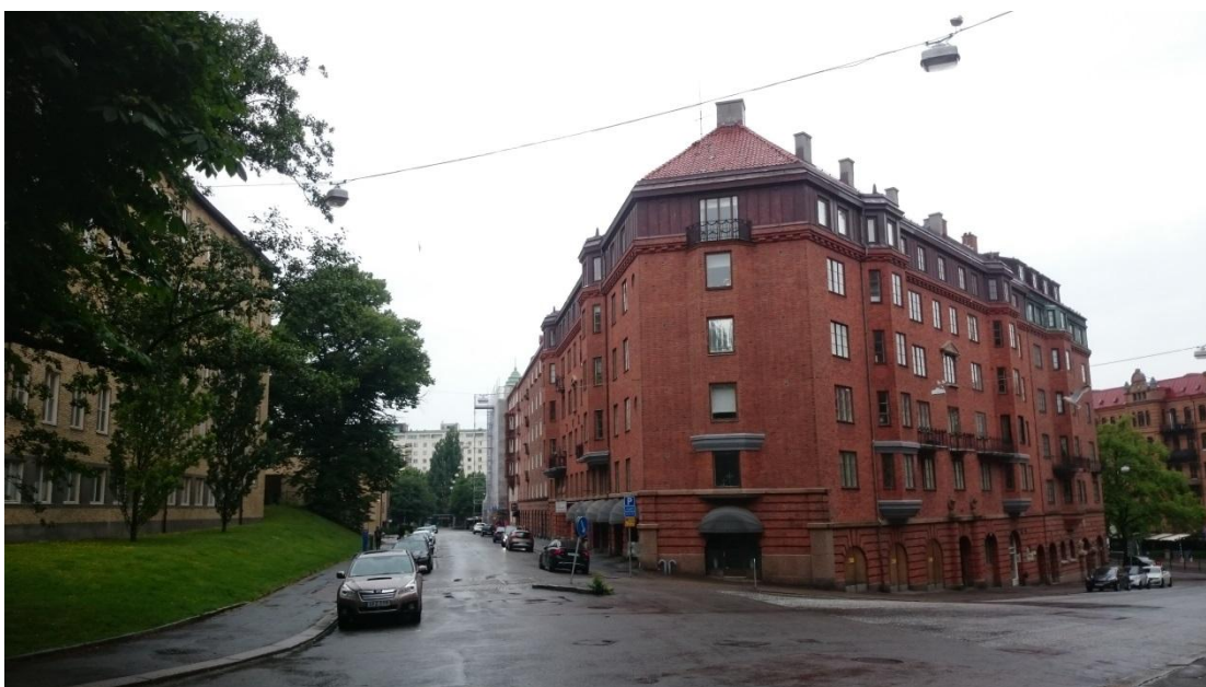
Väggkorsning mellan Johannebergsgatan i mitten av bilden och Olof Wijksgata som fortsätter ner till höger i bilden. Med den före detta Flickskolan som idag är en del av Artisten till vänster i bild och bostadskvarteret Ulrikedal till höger i bild
