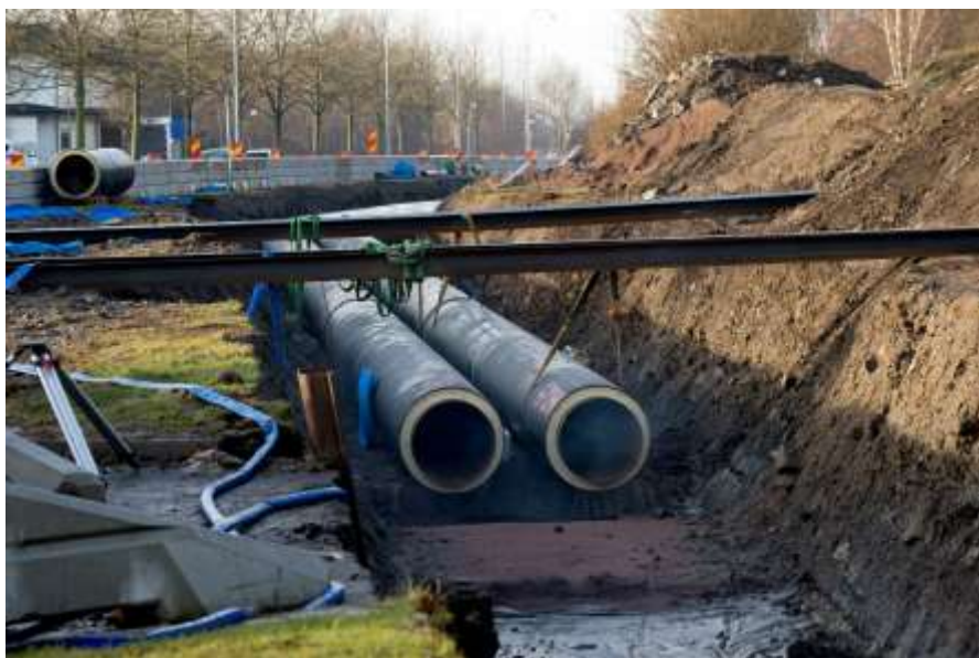
Figur 8. Utbyte av fjärrvärmerör är resurskrävande arbete och måste planeras med omsorg för att bli kostnadseffektivt. Bilden visar nedläggning av MBA-stammen på Hisingen. Foto: Jeanette Larsson
