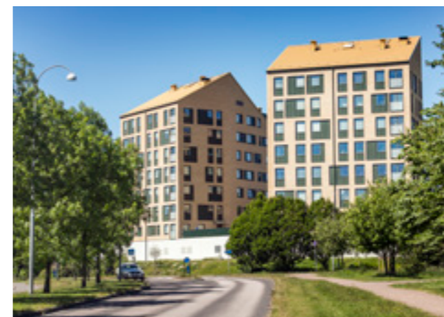
På 2010-talet byggdes det fler bostadsrättslägenheter och byggdes i områden där infrastruktur redan var etablerad. På bilden visas bostadsrättshus i Kyrkbyn, Lundby.
