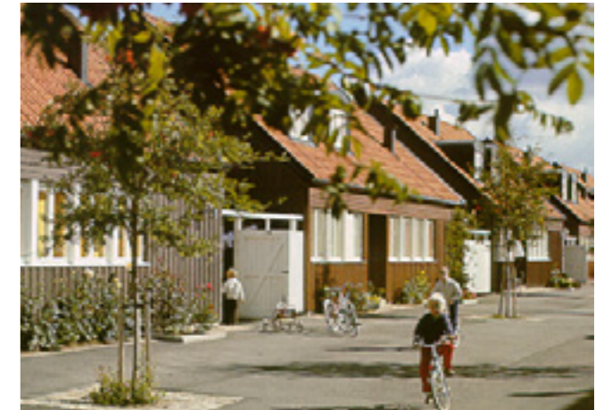
På 1960- och 70-talen byggdes stora familjeområden som idag kallas för de stora "radhusmattorna". Det var nyckelfärdiga radhus. Här på bilden visas radhus i Åkered.
