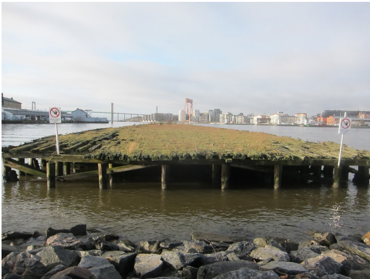
Figur 16 Fotografi över kajkonstruktionen i delområde 8.
