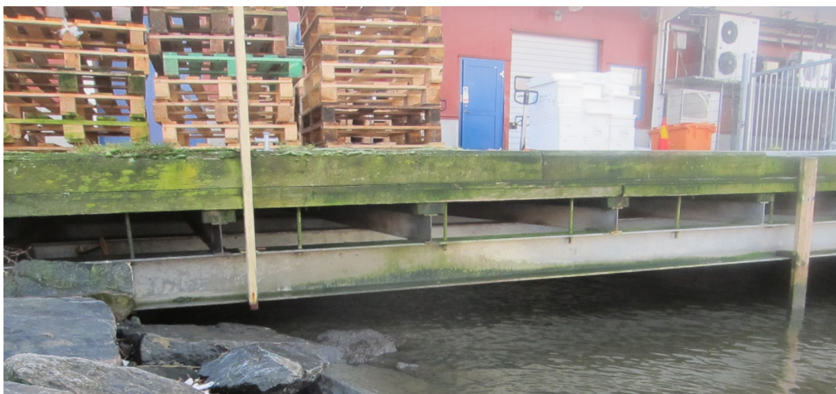
Figur 8 Fotografi på kajkonstruktion i delområde 4.
