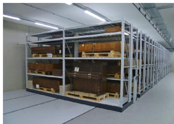
EXEMPEL PÅ MOBILA FÖRVARINGSSYSTEM. FRÅN VÄNSTER: PALLFÖRVARING, FÖRVARING I LÅNGSPANN, FÖRVARING I HYLLPLAN OCH LÅDOR, FÖRVARING AV KONST PÅ UTDRAGBART GALLER.
