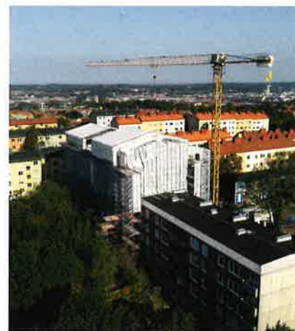
I samband med renoveringen på Hogenskildsgatan byggs husen på med ytterligare två våningar.
