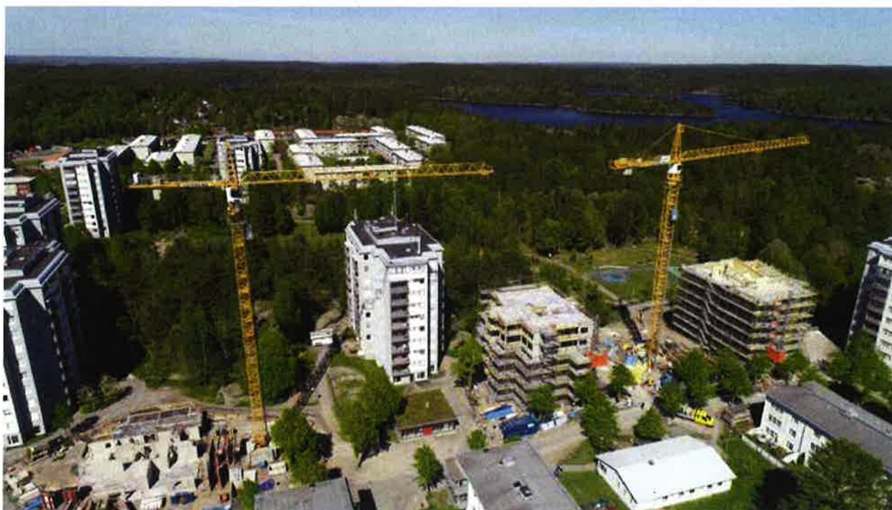
Byggnationen av Brf Övre Lövet i Lövgärdet, med Surtesjön i bakgrunden.
