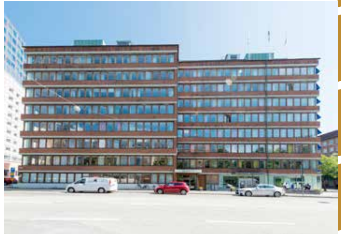
OMFATTANDE ÅTERBRUK. Vid renoveringen av fastigheten på Engelbrektsgränd 69-71 har flera material tagits till vara för återbruk.
