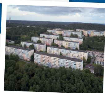
Renoveringen på Siriusgatan är igång.
