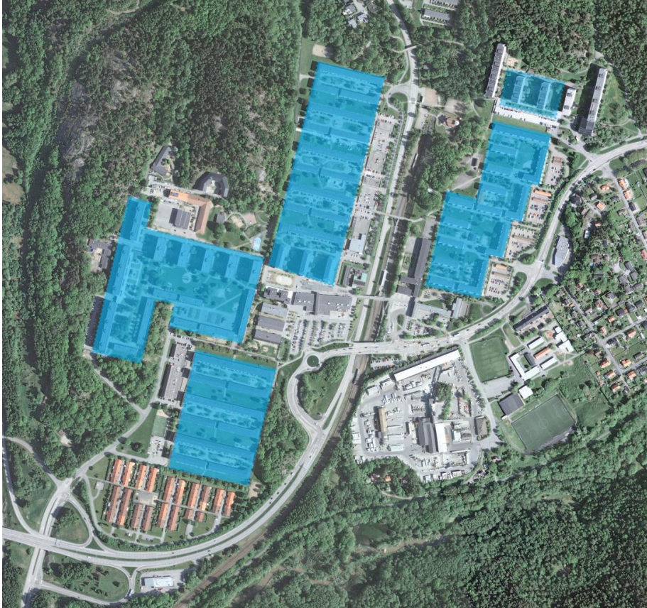
Renovering av befintligt bestånd
