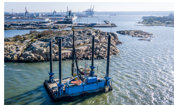
Pålningsarbete pågår i arbetet med Nya Arendal.
