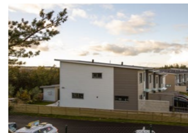
GÅRDSTEN BRF KRYDDHYLLAN, 34 radhus med bostadsrätt.
