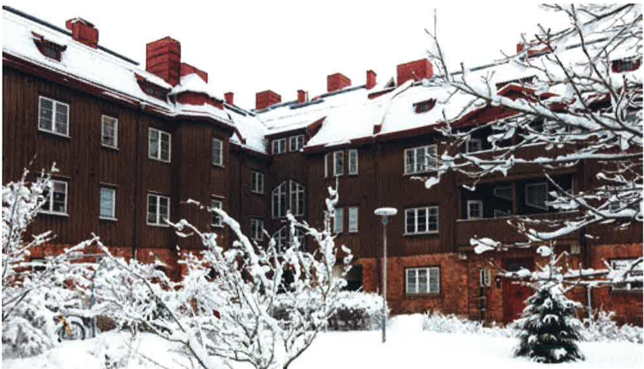
Poseidons fastigheter vid Uddevallplatsen, Redbergslid.
