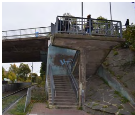
Trappa upp från spårvagnshållplatsen till Friskvåderstorget och Norra Biskopsgården
