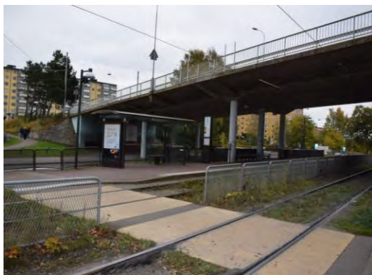
Hållplatsen Friskvåderstorget är beläget under Flygvådersgatans vägbro.
