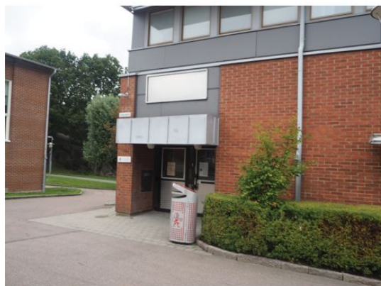
Bild ovan, fasad mot öster Bild nedan, nuvarande entré mot söder
