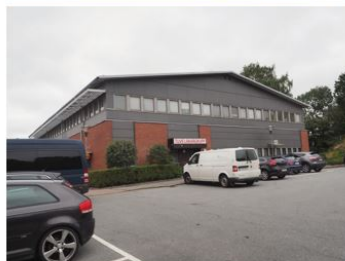
Bild ovan, befintlig trappa i sydväst. Bild nedan, parkeringsyta öster om byggnaden.
