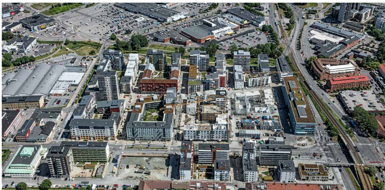
Flygvy över nya Kvillebäcken under uppförande 2015, sett från väster. Foto: Göteborgs Stad
