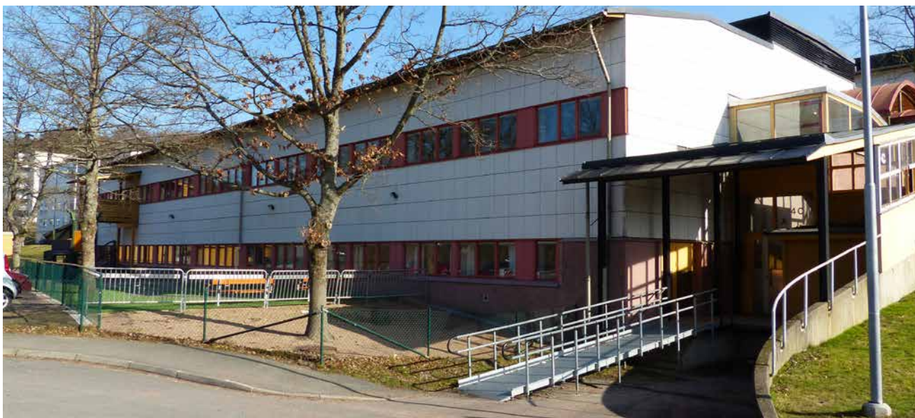
St Jörgens administrationsbyggnad med fasader i plåt och glasade gångar. Foto: Magnus Haglund
