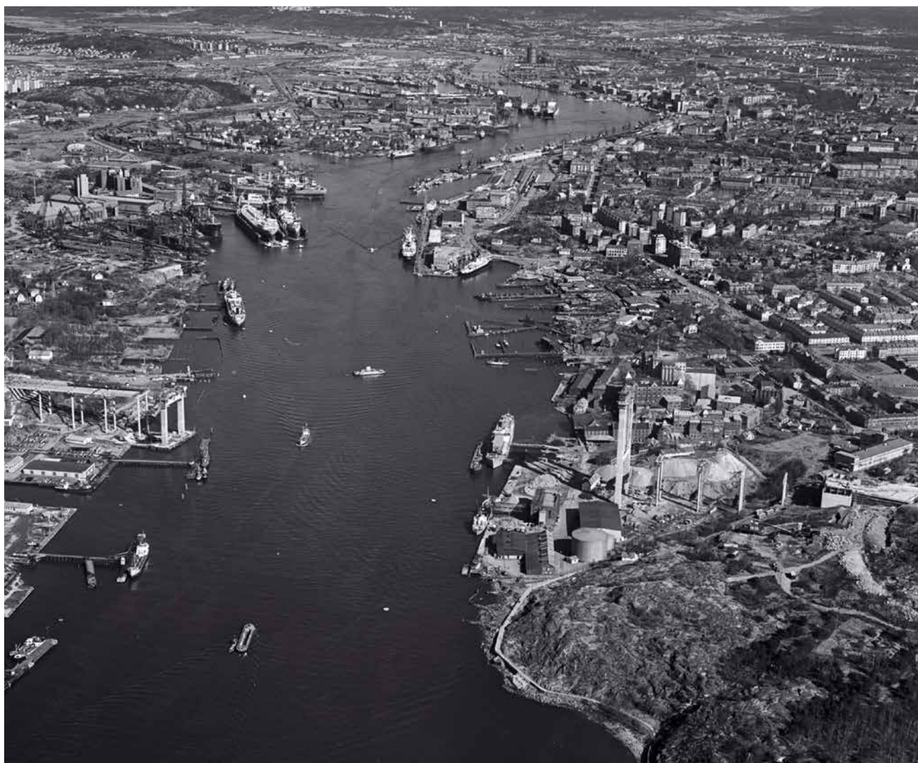
Flygbild över Älvsborgsbron under uppförande, sett från väster. Foto: Jan Olsson
