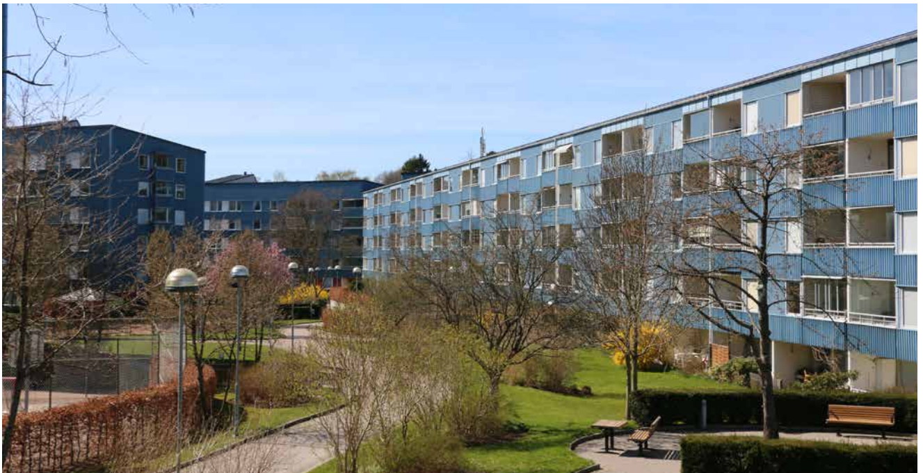
Blå staden eftersom alla fasader är blå, men även andra färgaccenter finns i området. Foto: Rickard Ribbås
